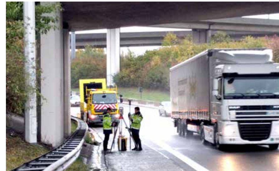
De bermen van de Brusselse ring zijn erg onherbergzaam. Hier kon alleen gemeten worden met GNSS en totaalstation, weliswaar met botsabsorbeers om zo veilig mogelijk te kunnen werken.
