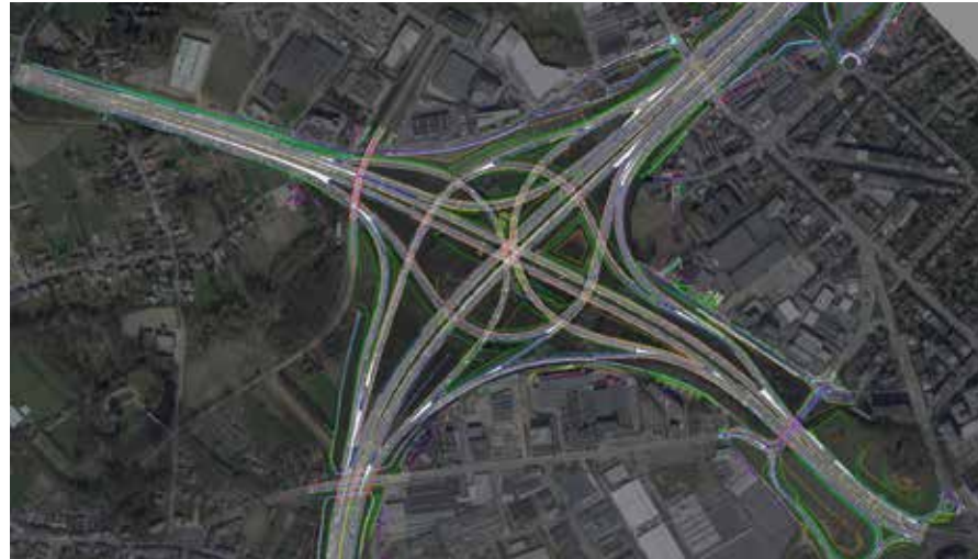
De verkeerswisselaar van Groot-Bijgaarden is één van de drukste knooppunten van het land. Door de combinatie van mobile mapping, 3D-laserscanning, GNSS en totaalstation werd de bestaande toestand veilig, efficiënt en met zo weinig mogelijk verkeershinder opgemeten.
